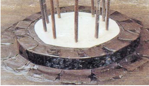
Kazık başı - klasik SBS katkıli bitümlü membran ile
