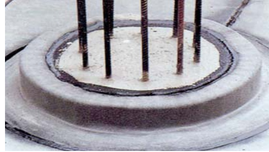
Kazık başı - Flexobit membran ile
