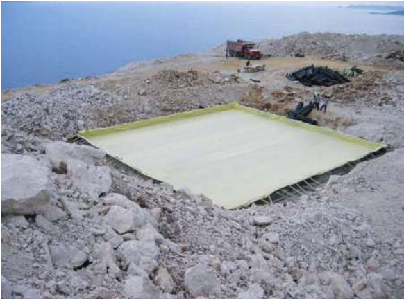
Grobeton Üzeri Su Yalıtımı
