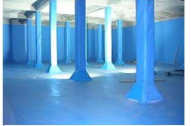
İçme Suyu Deposu Yalıtımı
