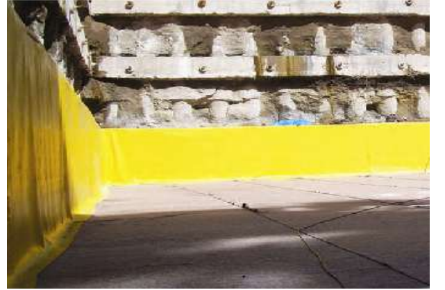
Betonarme Perde Yalıtımı
